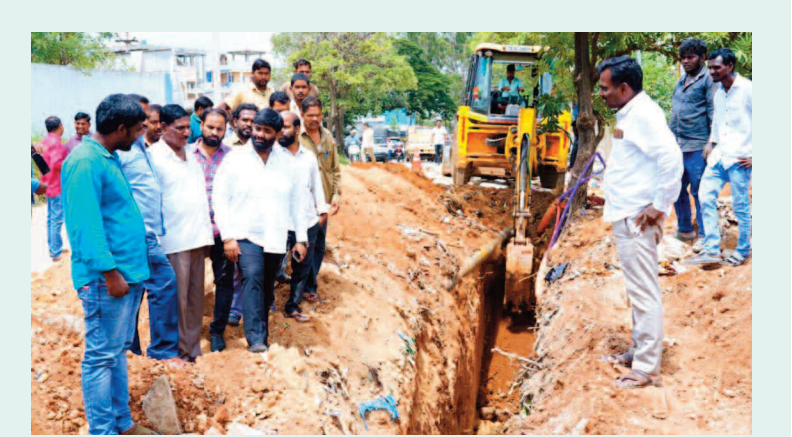
మధురా నగర్‌లో డైనేజీ పైన్ లైన్ పనులను పరిశీలిస్తున్న కార్పొరేటర్ తోకల శ్రీనివాస్ రెడ్డి
