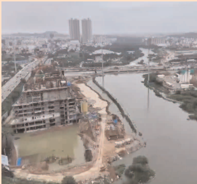
జెటర్ లింగ్ రోడ్డు నార్మంగి చౌరస్తా వద్ద బఫర్ జోన్లో నిర్మిస్తున్న భారీ భవన నిర్మాణాలు
