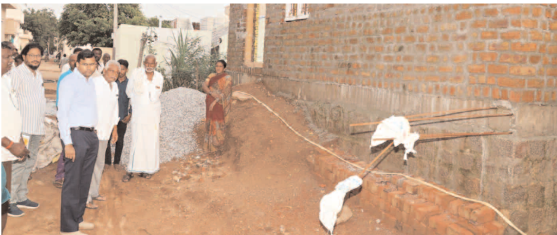
ఇందిరమ్మ ఇండ్ల నిర్మాణ పనులను పరిశీలిస్తున్న కలెక్టర్ సంతోష్
