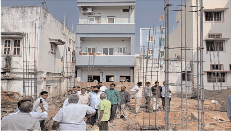
ప్రేమావతిపేట లో కమ్యూనిటీ హాల్ నిర్మాణ పనులను పరిశీలిస్తున్న కార్పొరేటర్ తోకల శ్రీనివాస్ రెడ్డి
