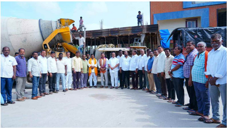
వ్యాపార సముదాయం నిర్మాణ పనులను ప్రారంభించిన ఎమ్మెల్యే మహిపాల్ రెడ్డి పటాన్చెరు, ఆగస్టు 9 (నమస్తే ఉదయం):
